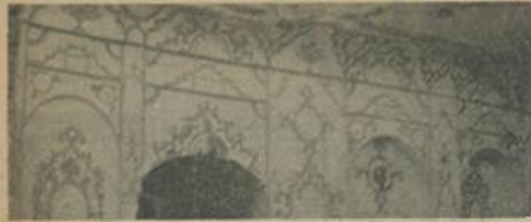
نمایی از دیوار خانه قدیمی «خانقاه الممالک» اصفهان که تخریب شد
